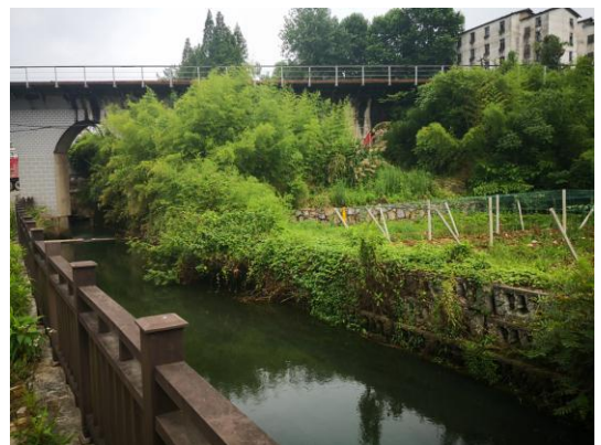
顶管穿越水渠
