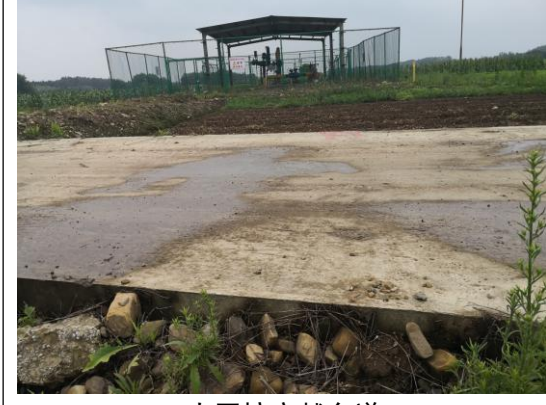
大开挖穿越乡道
