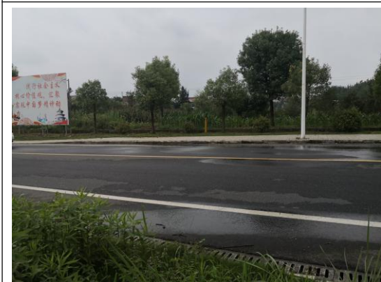
顶管穿越公路
